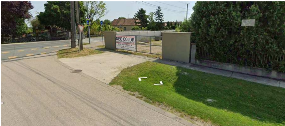
Csapadékvíz elvezető és szikkasztó árok a Mártírok útja mentén
