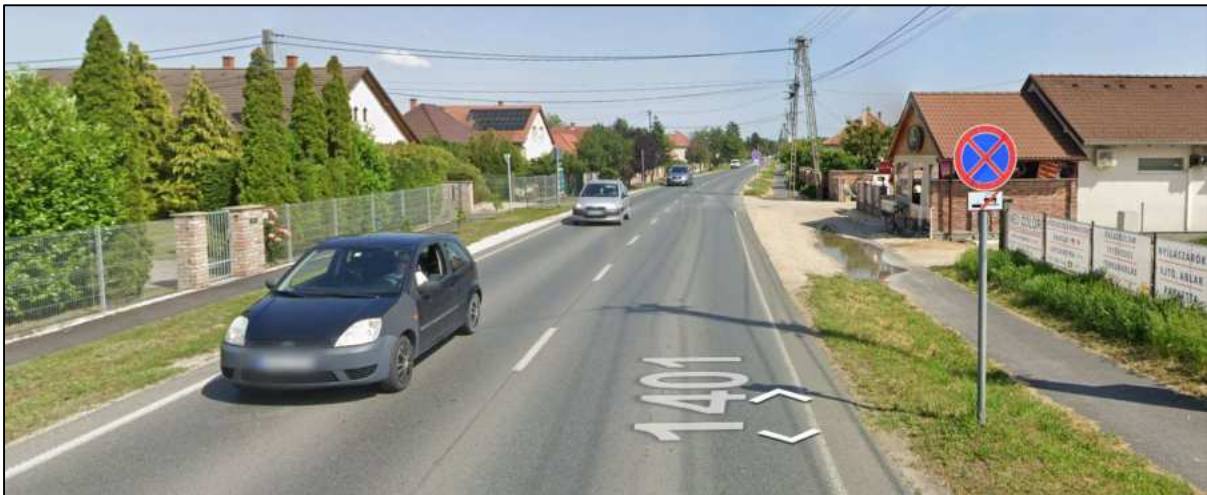
Csapadékvíz elvezető és szikkasztó árok a Mártírok útja mentén
